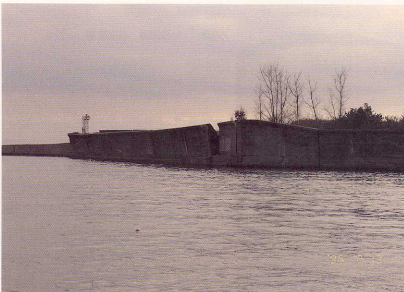
写真-18 神戸市長田区南駒栄町 岸壁損壊
