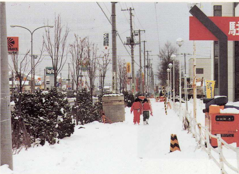
写真-L3 北海道釧路町木場・1993年釧路沖地震 マンホールが約1.5m浮き上がった。
