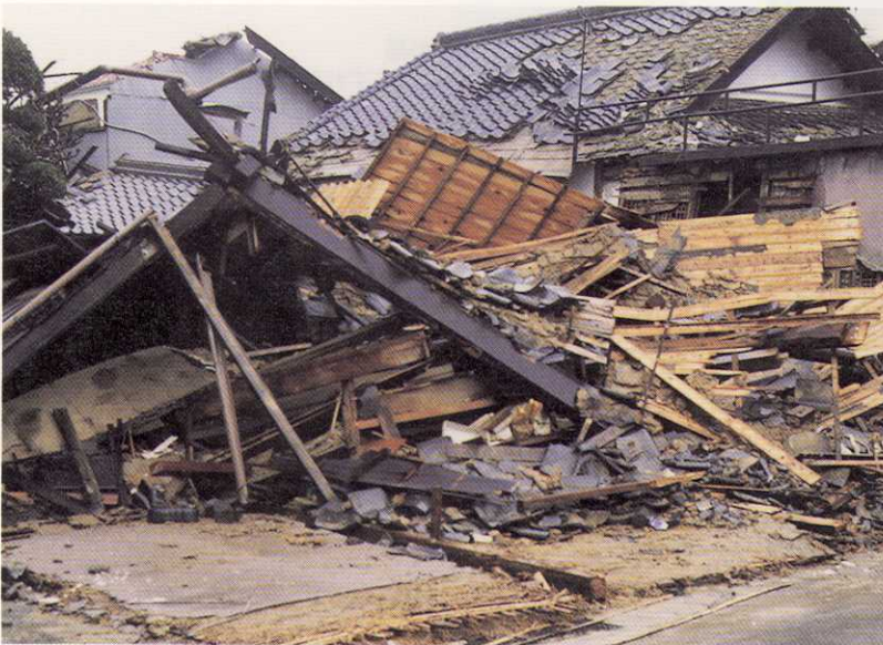
写真-3 北淡町富島・木造家屋の倒壊 屋根瓦の下に土を載せている木造家屋の倒壊が目立った。
