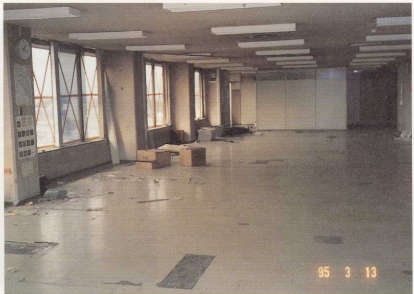
写真14 西宮市役所庁舎内部の状況 (環境保全課、環境監視センターの移設跡)
