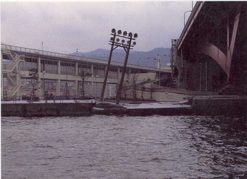
写真-6 神戸港 神戸大橋下 岸壁・照明等損壊
