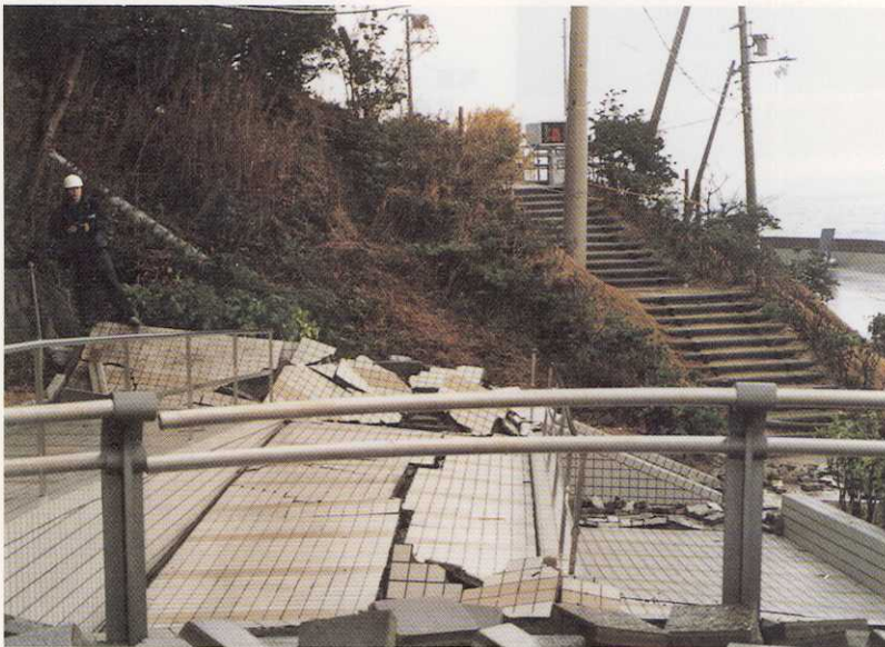
写真-12 北淡町江崎・江崎灯台下 地震断層が階段の左側を走り、海に突入していた。
