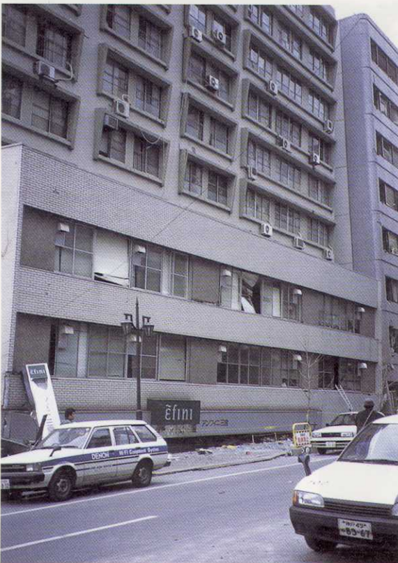
写真-54 神戸市中央区磯部通4丁目 写真-53の向かいにある3階建ての建物の1階部分が完全に崩壊した。
