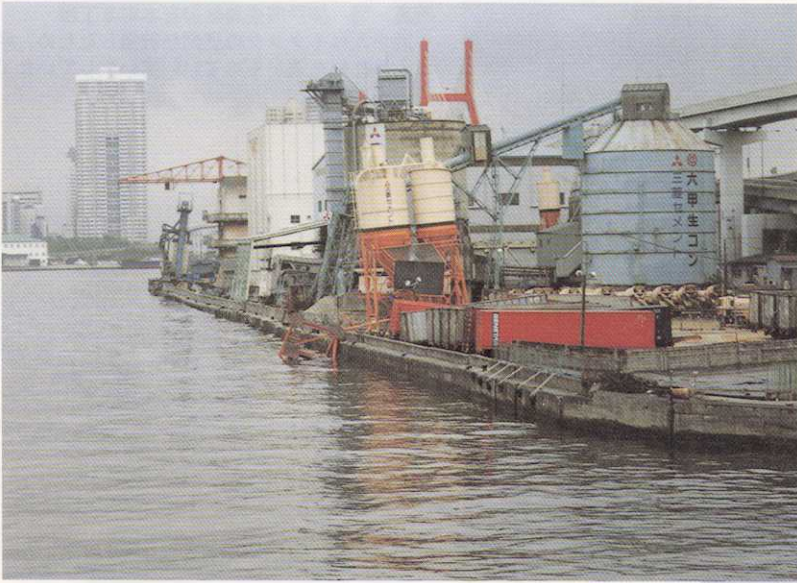
写真-82 神戸市東灘区住吉浜町 護岸が少し海側に移動したため、背後地盤に亀裂や陥没が生じ、工場施設に大きな被害が生じた。
