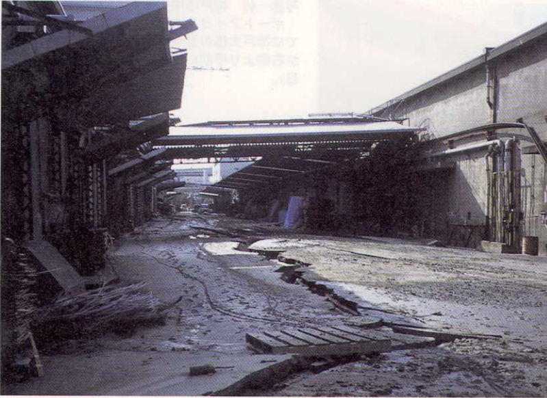
写真-53 神戸市中央区磯部通3丁目 液状化によって電柱脇や道路脇から砂が噴き出した。電柱は転倒し、左の建物にせん断破壊が生じていた（採取番号-6）。
