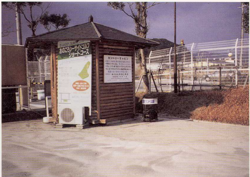
写真-20 津名町塩田・塩田新島 おのころアイランドではほぼ全面的に液状化していたが、噴き出した砂の量は非常に少なかった。
