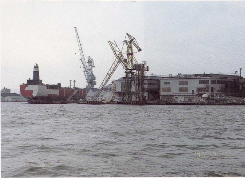
写真-4 神戸港 中央区東川崎町 クレーン・建物等損壊
