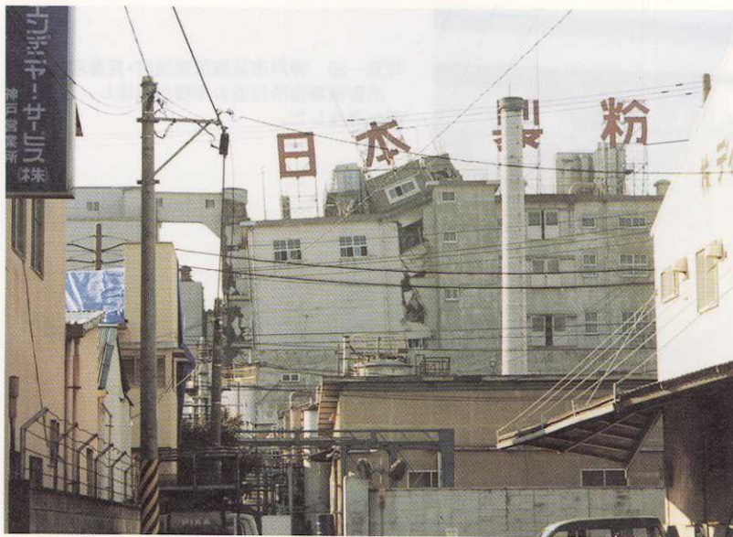
写真-27 神戸市兵庫区明和通2丁目 製粉工場が著しく破壊していた（2月6日）。
