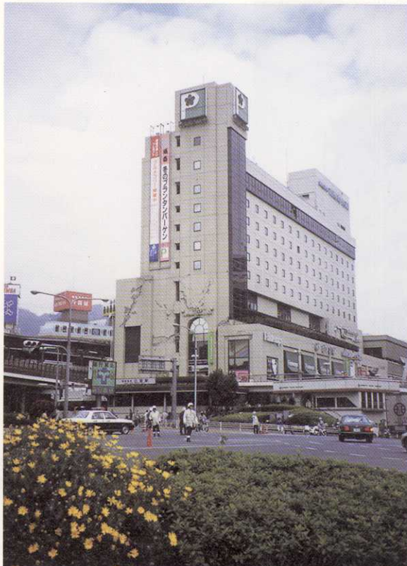
写真-63 神戸市中央区雲井通8丁目 ターミナルホテルが入っている三宮の駅ビルでは、壁や柱にせん断亀裂が生じていた。この地下にも被害が及んでいた。
