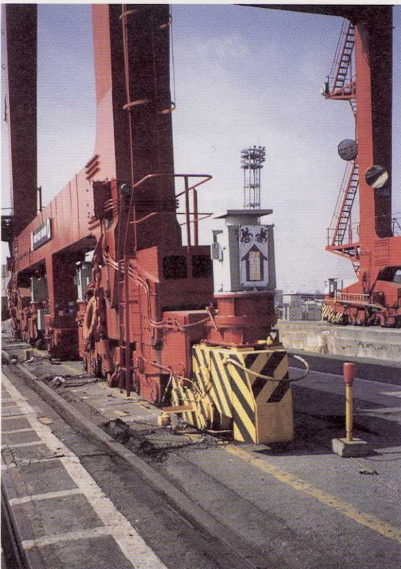
写真-45 神戸市中央区港島5丁目 ポートアイランドの北埠頭にある軌道式荷役機が脱線した。舗装板の傷を見ると一度飛び上がったから陸側に移動したようである。
