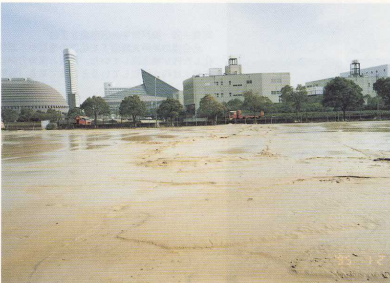
写真-42 神戸市中央区港島中町5丁目 広大な駐車場では、液状化に伴って多量の泥水が噴き出した。全面を覆っている泥水はまだ乾いておらず、舗装面に薄い皮膜を形成したため、非常に滑りやすい状態となっていた(1月21日)。
