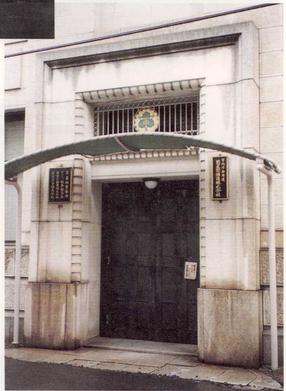
写真-80 神戸市東灘区御影本町1丁目 古くてもしっかりと造られていれば、構造的な被害は生じなかった。
