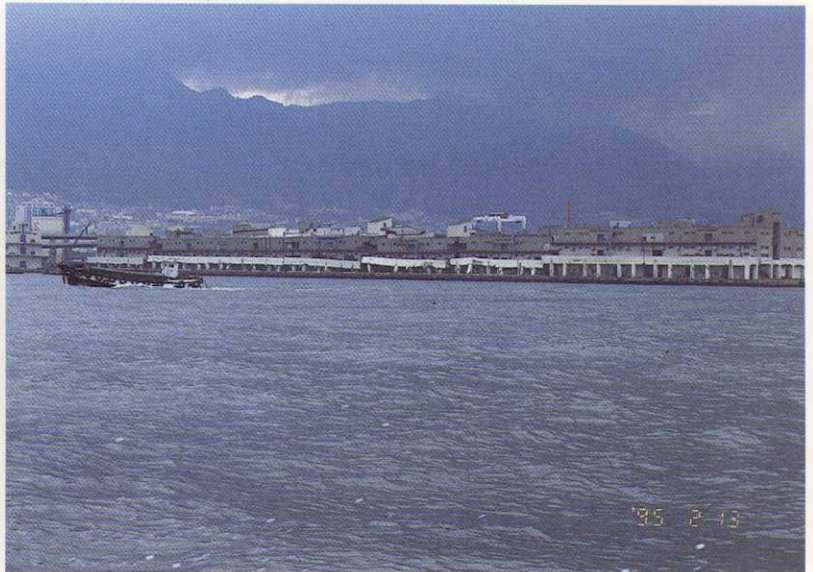
写真-8 神戸港 中央区小野浜町 港湾施設損壊
