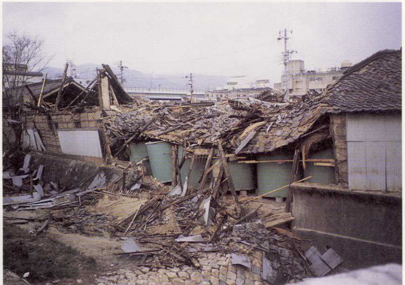
写真-77 神戸市東灘区御影塚町1丁目 あちこちで酒蔵が破壊したため、酒の臭いが 漂っていた。
