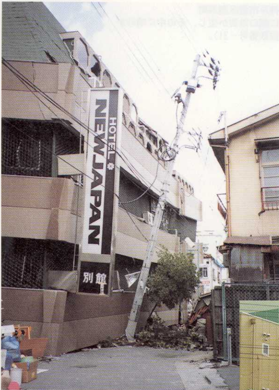
写真-67 神戸市中央区中山手通1丁目 ホテルの1階部分が手前に倒れるように破壊した。また、道路側に倒れ込んだ2階建ての家屋も見える。
