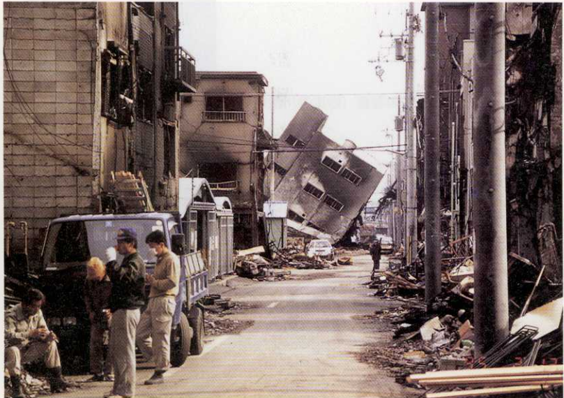
写真8 焼失倒壊家屋が多い地区（水笠通・神楽町）
