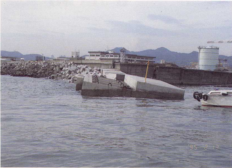
写真-16 神戸市長田区南駒栄町 防波堤損壊
