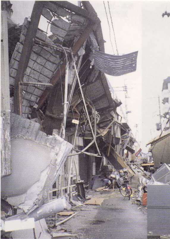
写真-73 神戸市灘区浜田町3丁目 阪神電鉄新在家駅の東側ではラーメン高架橋が破壊した。その向かいの建物の多くが全壊していた。
