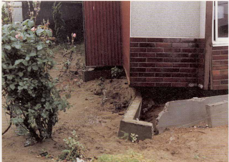
写真-L5 秋田県若美町五明光・1983年日本海中部地震 木造住宅の上屋がコンクリート製フーチングから1m以上も移動した。
