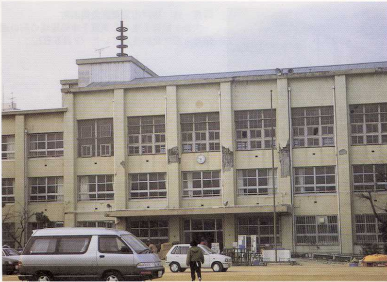
写真-94 神戸市東灘区青木4丁目・本庄小学校 鉄筋コンクリート製の柱にせん断亀裂が生じた。この後、校庭などにテントがならび住民の避難場所となり、頻繁にTV報道されるようになった。
