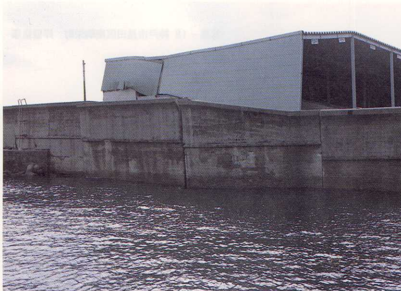
写真-15 長田港 岸壁損壊
