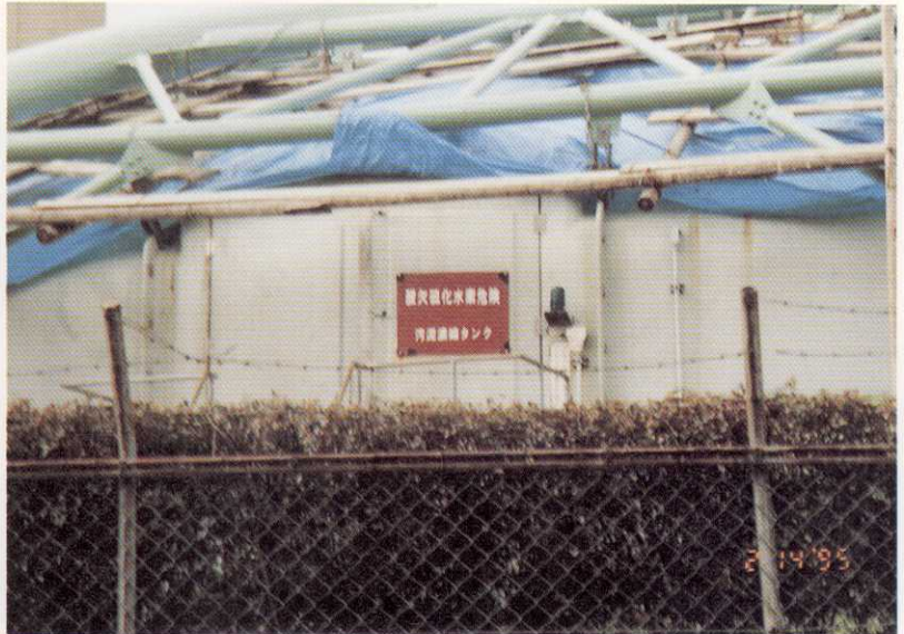
写真 6 東灘下水処理場のタンクの破損状況
