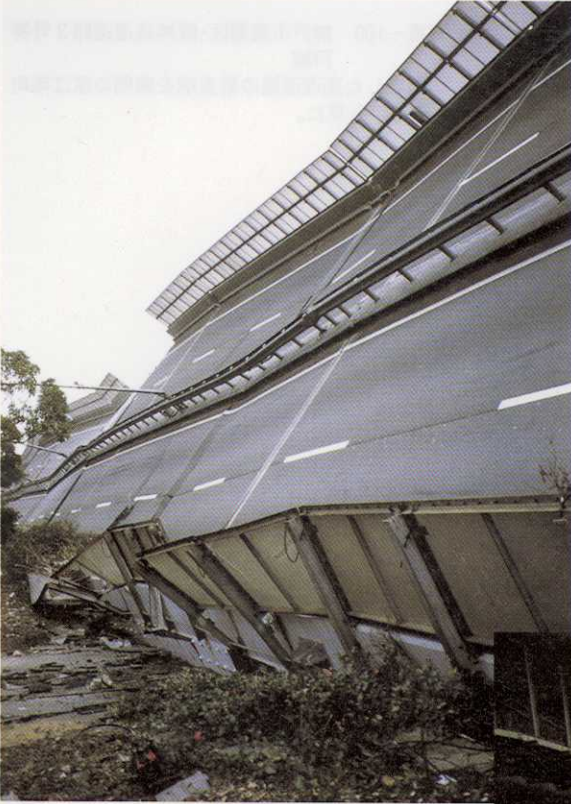
写真-97 神戸市東灘区・阪神高速道路3号神戸線
