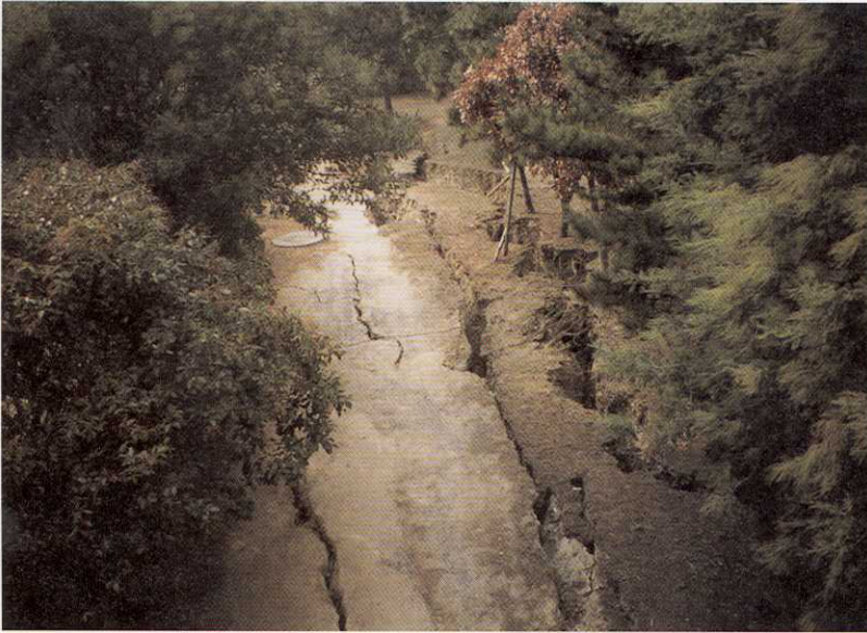
写真-109 芦屋市若葉町 宮川沿いでは擁壁が川の方に膨み出しており、その背後の地盤に亀裂が走り、噴砂も見られた。
