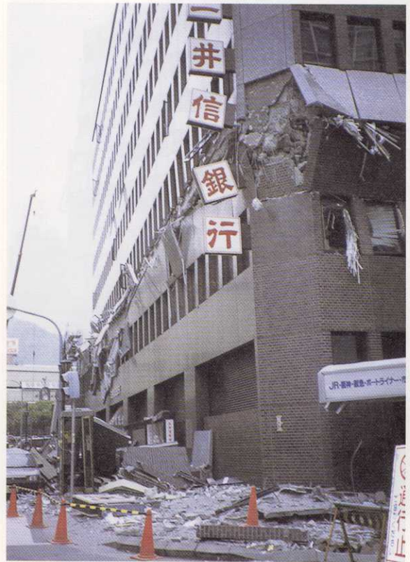
写真-62 神戸市中央区小野柄通7丁目 3階部分が潰れ、銀行の看板の一字が路上に落ちていた。
