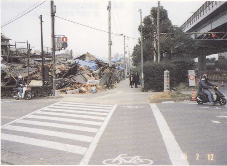
写真4 国道43号沿道の家屋の被災状況 (芦屋市宮川町付近)
