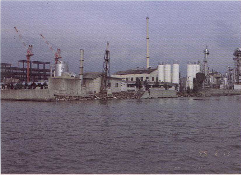
写真-19 神戸市長田区南駒栄町 岸壁・煙突 等損壊
