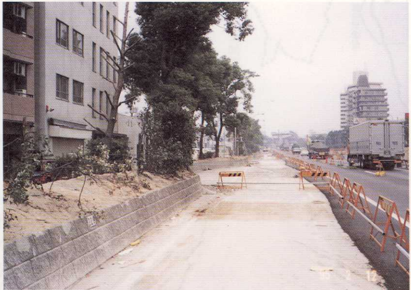
写真2 阪神高速道路神戸線の倒壊区間の緑地帯の状況（神戸市東灘区深江本町付近、倒壊区間西端から東側を望む）
