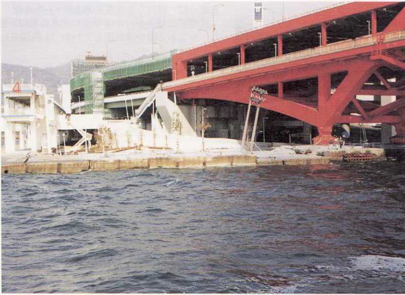
写真-49 神戸市中央区新港町・新港第四突堤 ポートアイランド側から見ると、突堤先端部 では神戸大橋の支承部がある所より左側の岸壁 が右側より手前に約2m移動していた（1月20 日）。
