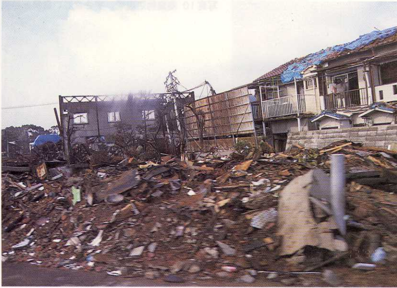
写真7 焼失し瓦礫に山、その隣のアパートには住民が（須磨区）
