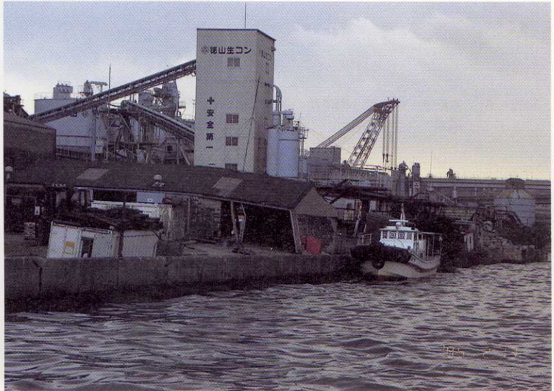
写真-11 神戸港 東灘区魚崎南町 岸壁・建物 損壊
