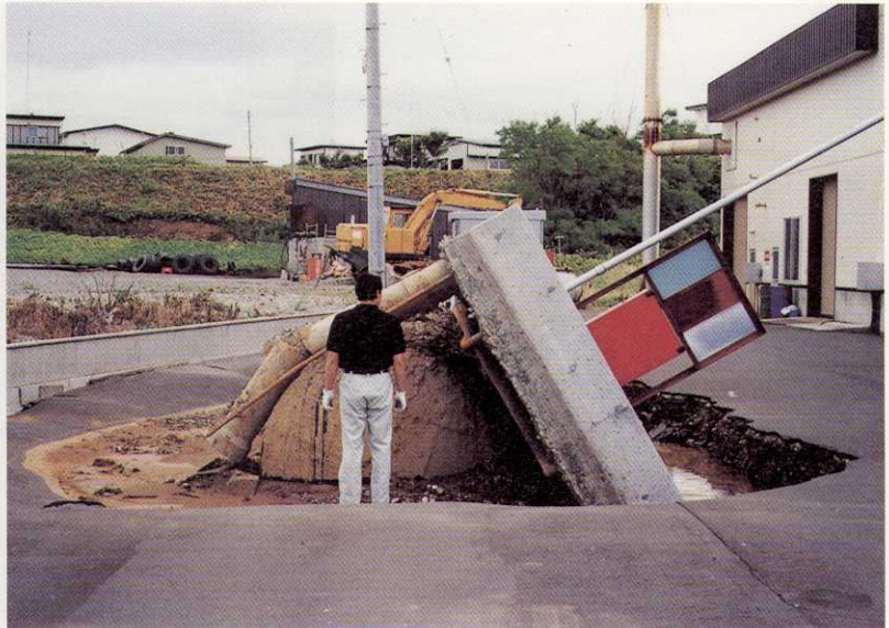
写真-L2 北海道江差町柳崎・1993年北海道南西沖地震 埋設されていた重油タンクが液状化により浮上し、転倒した。
