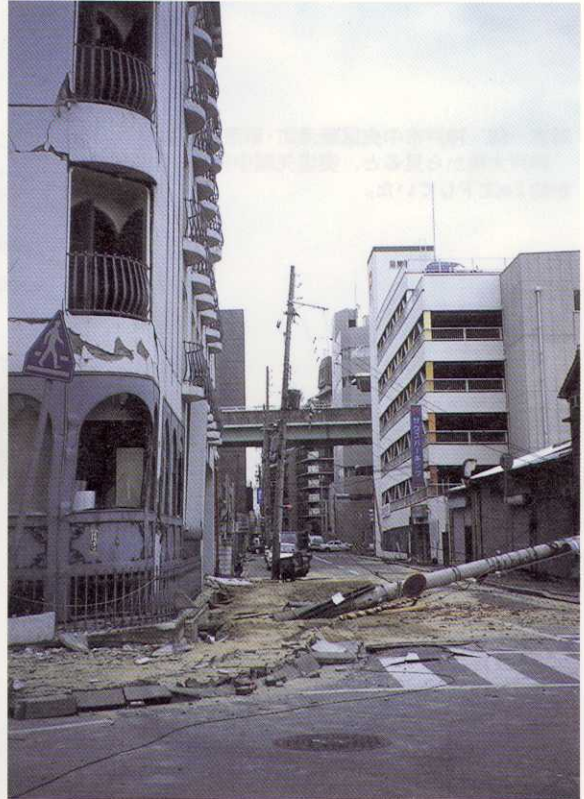
写真-53 神戸市中央区磯部通3丁目 液状化によって電柱脇や道路脇から砂が噴き出した。電柱は転倒し、左の建物にせん断破壊が生じていた（採取番号-6）。
