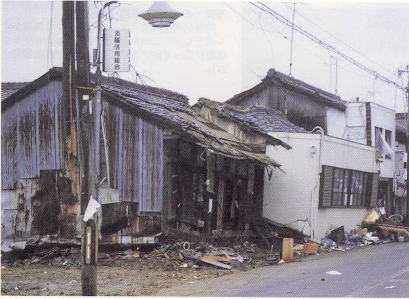
写真-1 一宮町郡家・2階家の倒壊 1階部分が、手前の家はべちゃんこに、次の家は道路側に傾いて倒れた（1月22日）。
