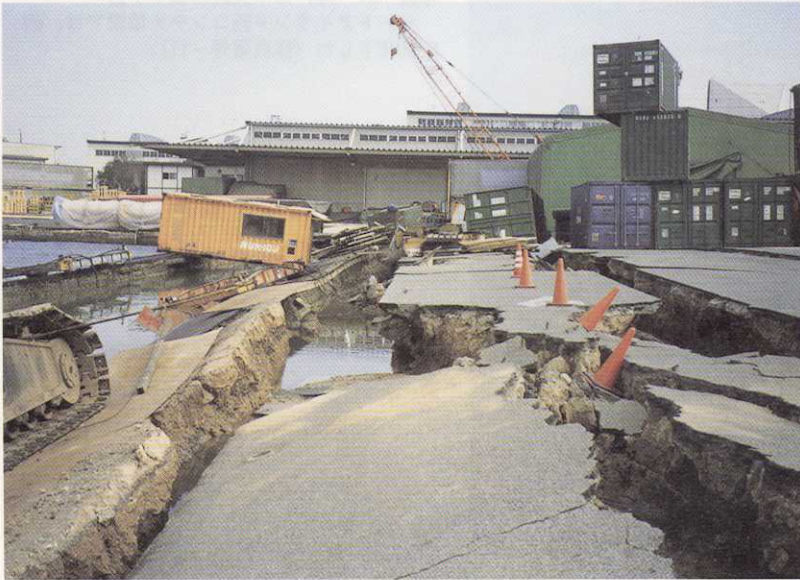
写真-34 神戸市中央区港島2丁目 液状化によって地盤は岸壁とほぼ平行に亀裂が生じて滑り崩壊した。岸壁は大きく海側へ移動し、海没した（1月20日）。
