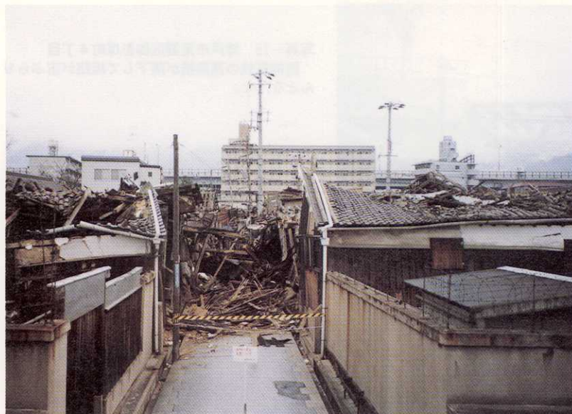
写真-78 神戸市東灘区御影石町1丁目 古い木造の酒蔵がいたる所で全壊していた。
