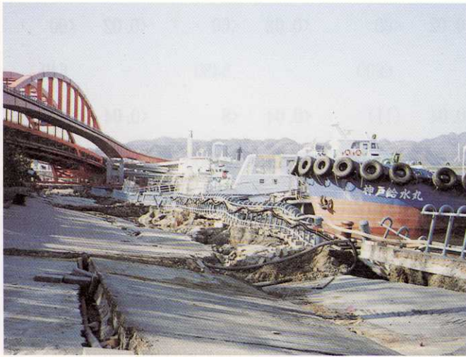
写真C 港町三丁目の港岸壁部
