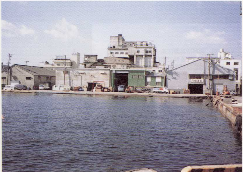
写真-29 神戸市兵庫区出在家町1丁目 岸壁が数10mにわたって崩壊し、エプロン部が 海没した(2月6日)。
