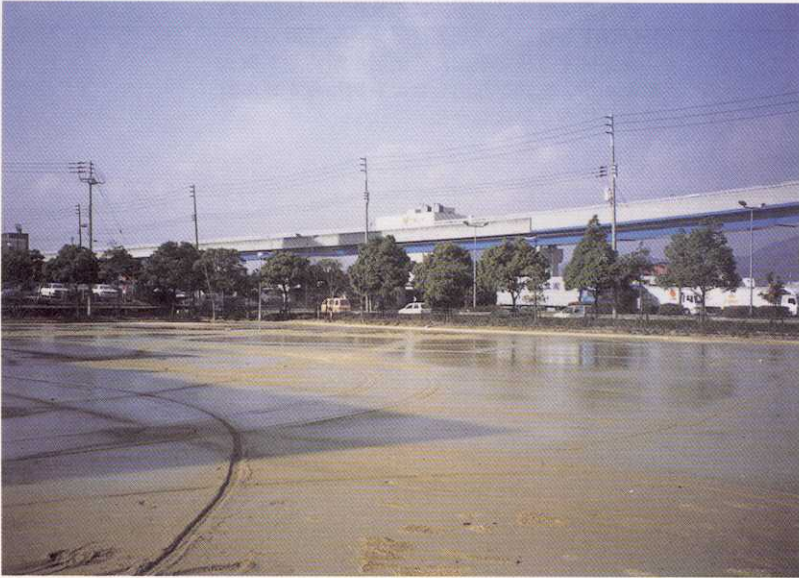
写真-43 神戸市中央区港島中町2丁目 神戸税関の駐車場でも液状化に伴って噴出した泥水はまだほとんど乾いていなかった（採取番号-12）。
