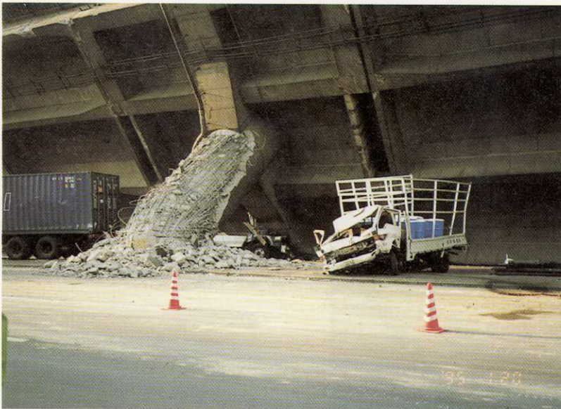
写真-99 神戸市東灘区・阪神高速道路3号神戸線
