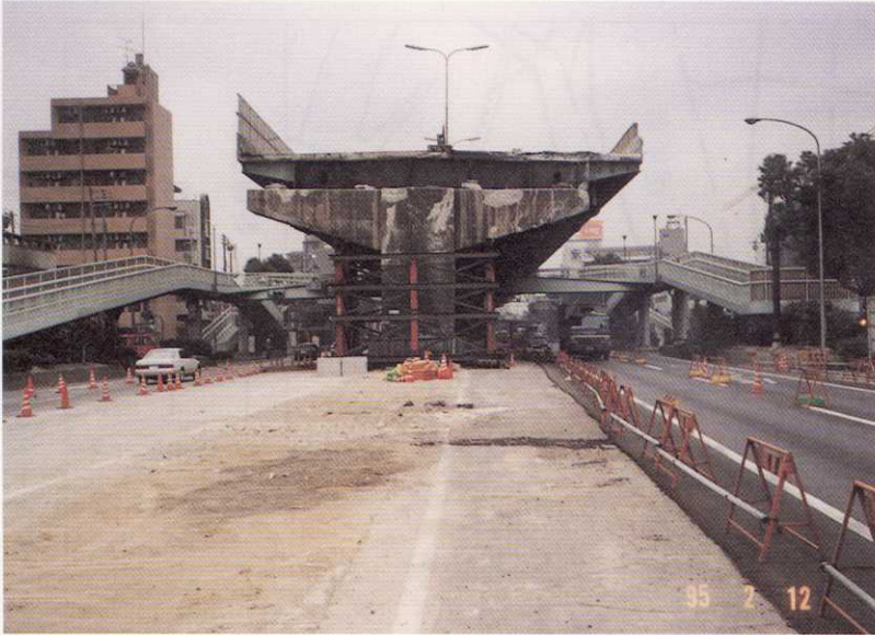
写真1 倒壊した阪神高速道路神戸線の撤去後の状況（神戸市東灘区深江本町付近、倒壊区間の西端）
