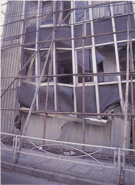
写真4 歪んだ窓枠と応急処置（須磨区山側）
