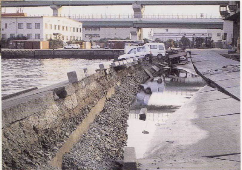
写真-71 神戸市灘区摩耶埠頭 埠頭の入口付近では岸壁が海側に膨み出し、エプロン部が大きく沈下していた。
