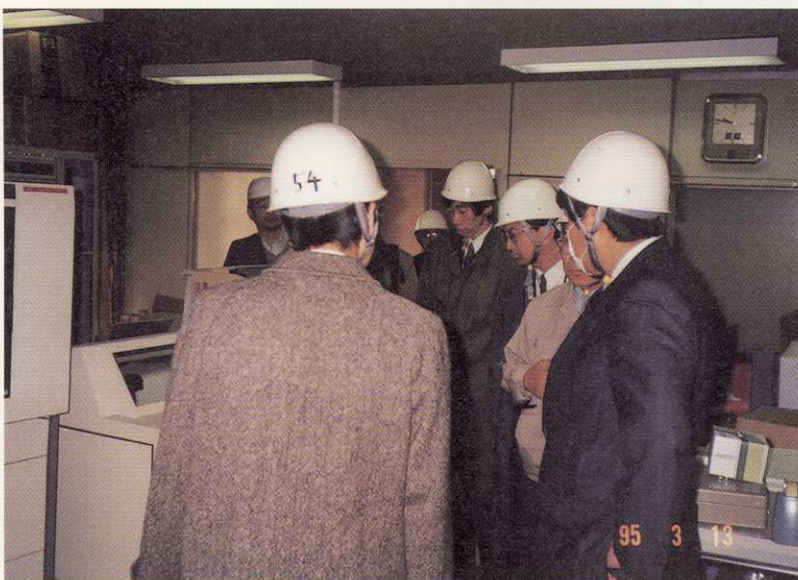
写真15 西宮市テレメータ室の状況
