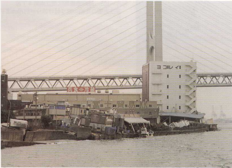
写真-106 神戸市東灘区深江浜町 岸壁が海側に移動し、その背後地盤が陥没したため、様々な被害が生じていた。
