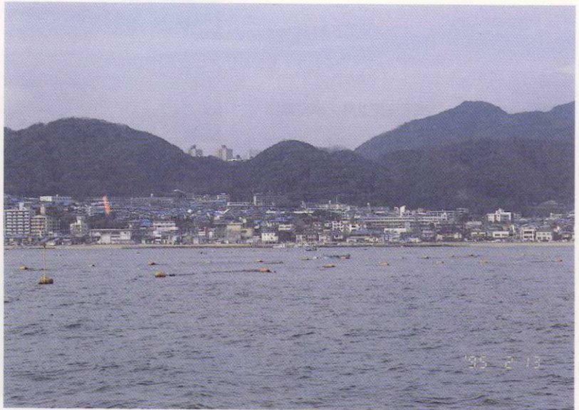
写真-23 神戸市須磨区 青色屋根の被災住宅
