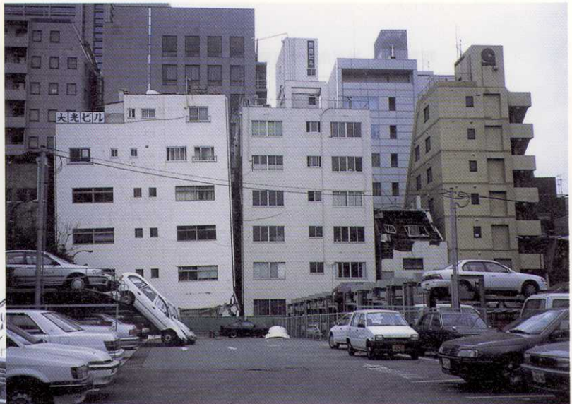
写真-56 神戸市中央区八幡通4丁目 裏通りから見ると、壊れたり、傾いたりしている建物がよく分かる。手前の駐車場では、上から乗用車が落ちていた。
