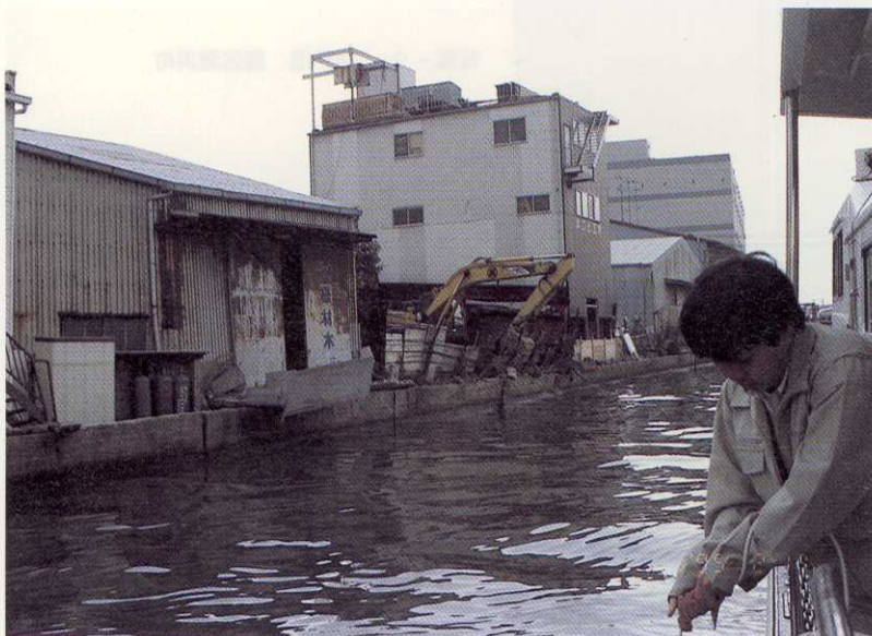
写真-12 神戸港 東灘区魚崎南町 岸壁損壊・ 建物傾斜
