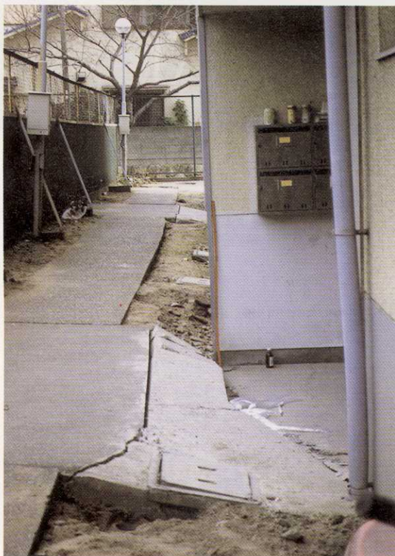
写真-120 西宮市南甲子園3丁目 液状化により、写真-119の建物の北側が20cm以上沈下したため、傾いた。
