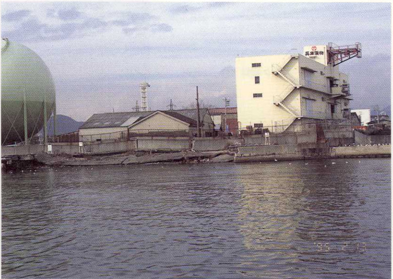
写真-18 神戸市長田区南駒栄町 岸壁損壊
