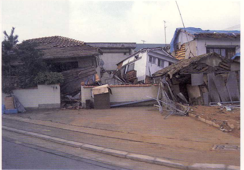
写真5 同じ敷地に全壊家屋と外見は無事な家屋（須磨区）
