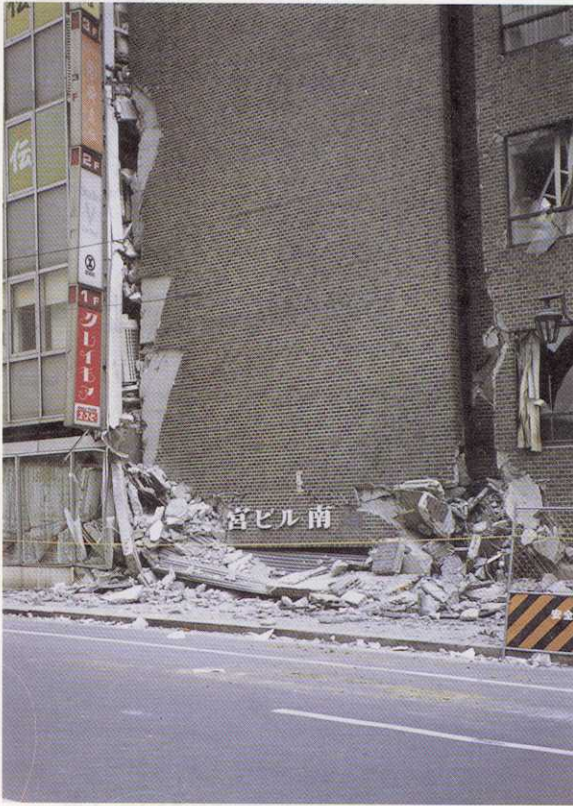
写真-61 神戸市中央区御幸通7丁目 三宮ビル南館の1階が押しつぶされるように破壊していた（1月20日）
