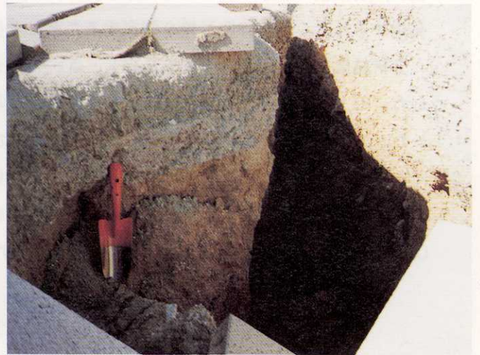
写真B 同上 亀裂断層
