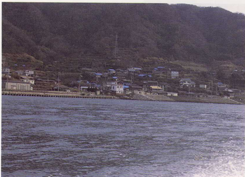
写真-24 淡路島北西部 青色屋根の被災住宅
