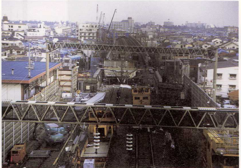
写真-122 西宮市甲東園4丁目・JR山陽新幹線 六甲トンネル出口付近から東側を見ると、あちこちで高架橋が落下するなどの被害が生じていた（2月8日）。
