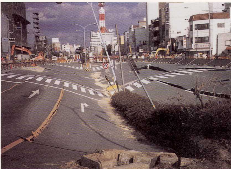
写真-21 神戸市兵庫区・阪神高速東西線大開駅 大開駅上の国道28号線は最大約3m沈下していた（2月6日）。
