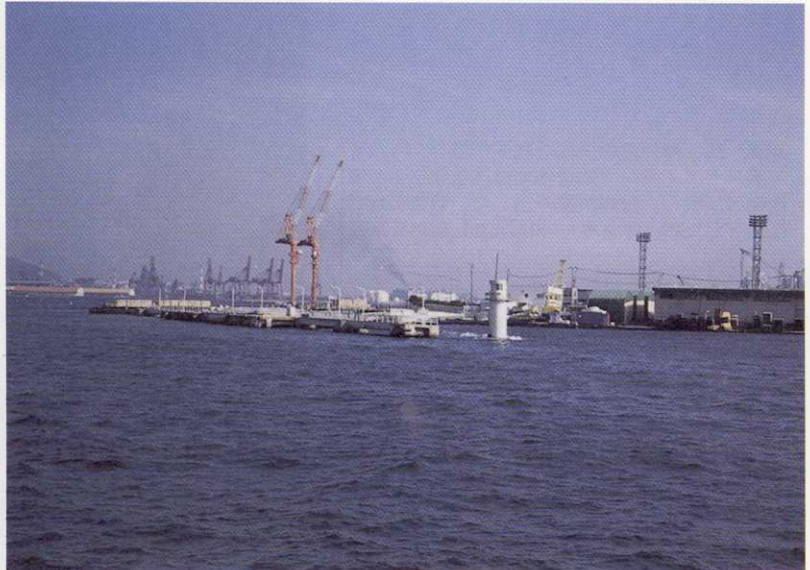
写真-41 神戸市中央区港島3丁目先 港の入り口にある防波堤の先端部やそれに接続している灯台は沈下し、水没していた。
