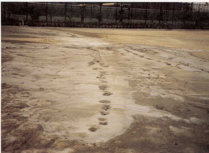
写真-111 西宮市西宮浜 大学のグラウンドでは、至る所で亀裂から砂が噴き出していた。
