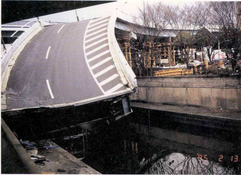
写真10：高速道路の落橋（湊川ランプ）
