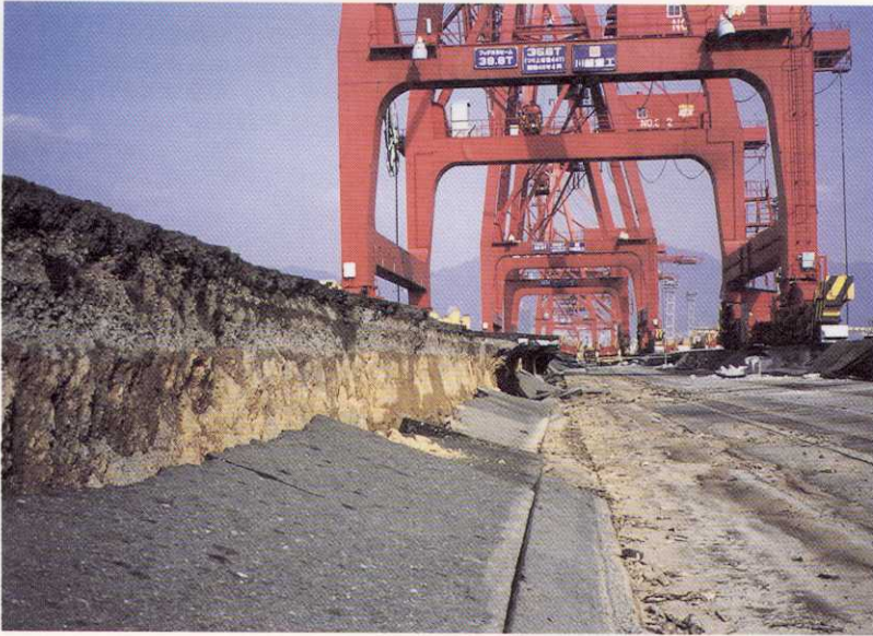
写真-31 神戸市中央区港島1丁目 ポートアイランド西コンテナ埠頭では、約 1.5m沈下した（採取番号-11）。
