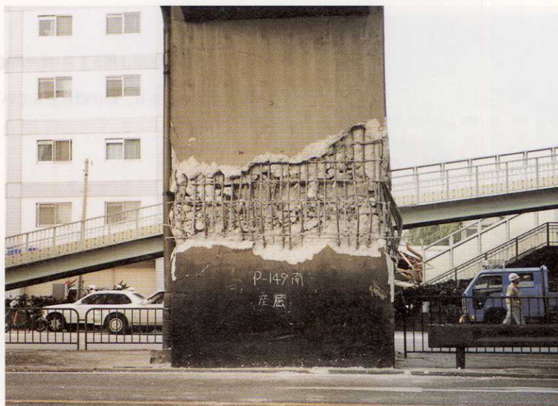
写真-96 神戸市東灘区・阪神高速道路3号神戸線
