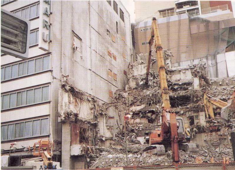
写真19 神戸市内におけるビルの解体現場（JR元町駅南側）
