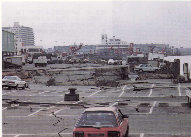
写真-90 神戸市東灘区魚崎南町1丁目 地盤が滑って、海側に大きく移動したため、岸壁に駐車していた自動車は何台も陸側に戻れなくなり、置き去りにされた。
