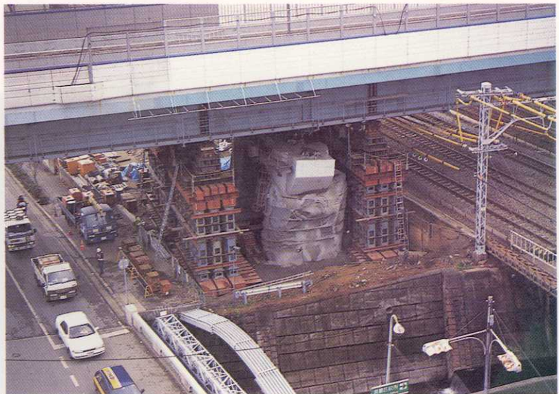
写真2 歪んだ橋脚の補修作業 (公害研究所前)
