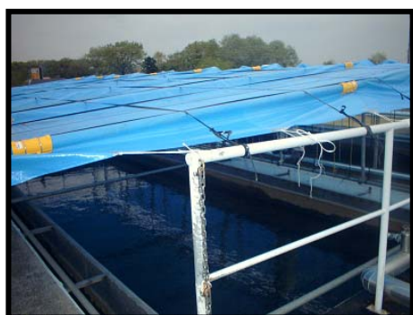
【守谷市 守谷浄水場 沈殿池 覆蓋】
