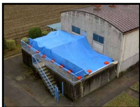
【筑西市 成田浄水場 着水井 覆蓋】
