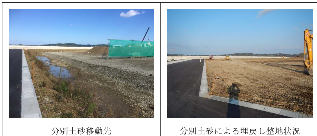
写真 1.2-5 埋戻し部の状況
