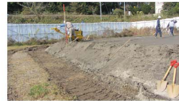
(a) 施工中の締固め状況
