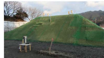
(b) 設置完成後の試験盛土(分別土A種)
