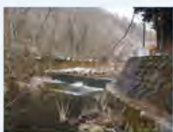
鉄山ダム下流
