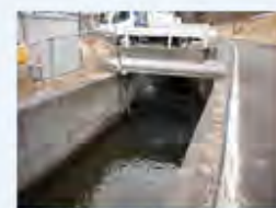
横川ダム放流水路
