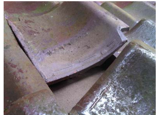
図 3.2-24 母屋北側側瓦上ダスト
