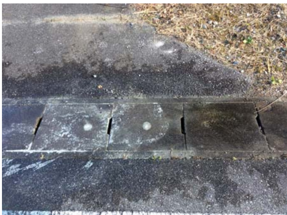
図 1.3-9 No.9, 10 高線量地区側溝蓋(左) (空間線量率 22.3 \mu\text{Sv/hr} ) No.11 コンクリートブロック(右) No.14 は No.11 の側面 (空間線量率 12.5 \mu\text{Sv/hr} )
