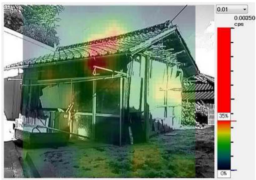
図 3.2-31 解体前の被災建築物（TB-2：物置）（1）からの放射能蓄積分布
