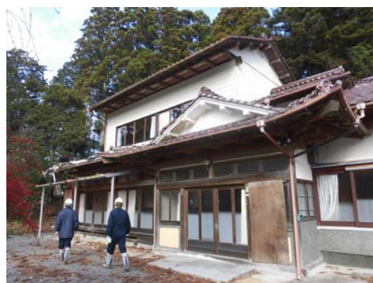
図 3.2-22 母屋南東側から撮影
