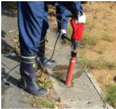
図 1.3-2 浪江町 駐車場端の側溝蓋
