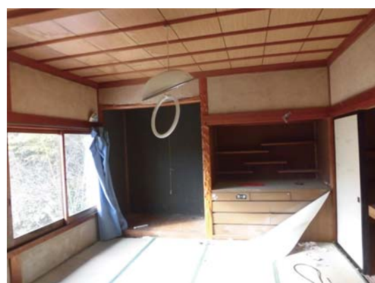
図 3.2-20 母屋 2 階西側和室
