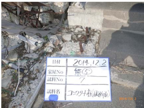
図 1.3-8 倒壊した臨海建築物 No.7 倒壊柱破断面(左) No.8 倒壊柱表面(右) (空間線量率 5.8 \mu\text{Sv/hr} )
