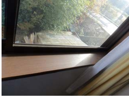
図 3.2-12 離れ 2F 洋室 6 畳間南東部窓枠
