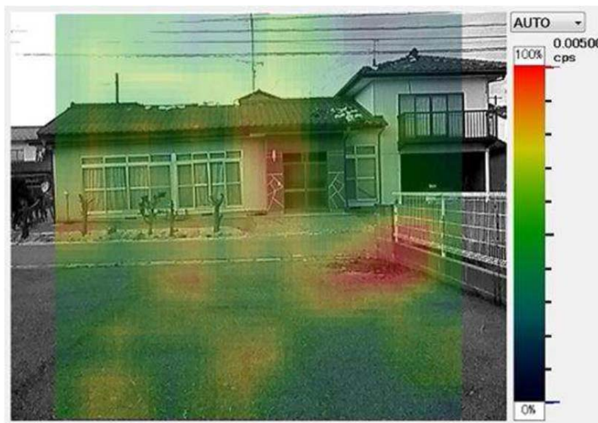
図 3.2-35 解体前の被災建築物 (TB-3) 正面 (1) からの放射能蓄積分布
