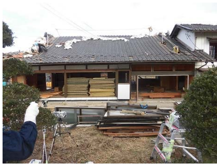
図 3.2-10 母屋正面(瓦降ろし前)
