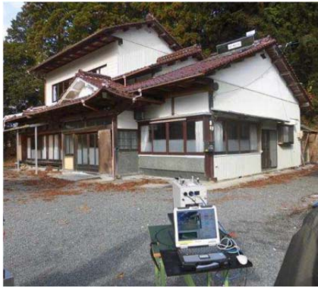
図 3.2-26 解体前の対象家屋 (TB-1)
