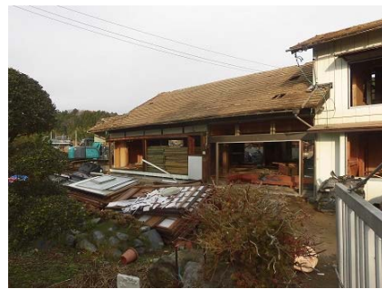
図 3.2-11 母屋正面(瓦降ろし後)
