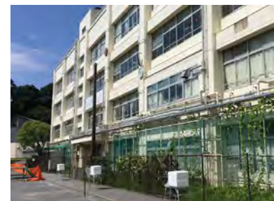
図 2 熱線再帰フィルムを貼った 教室をグラウンドから撮影
